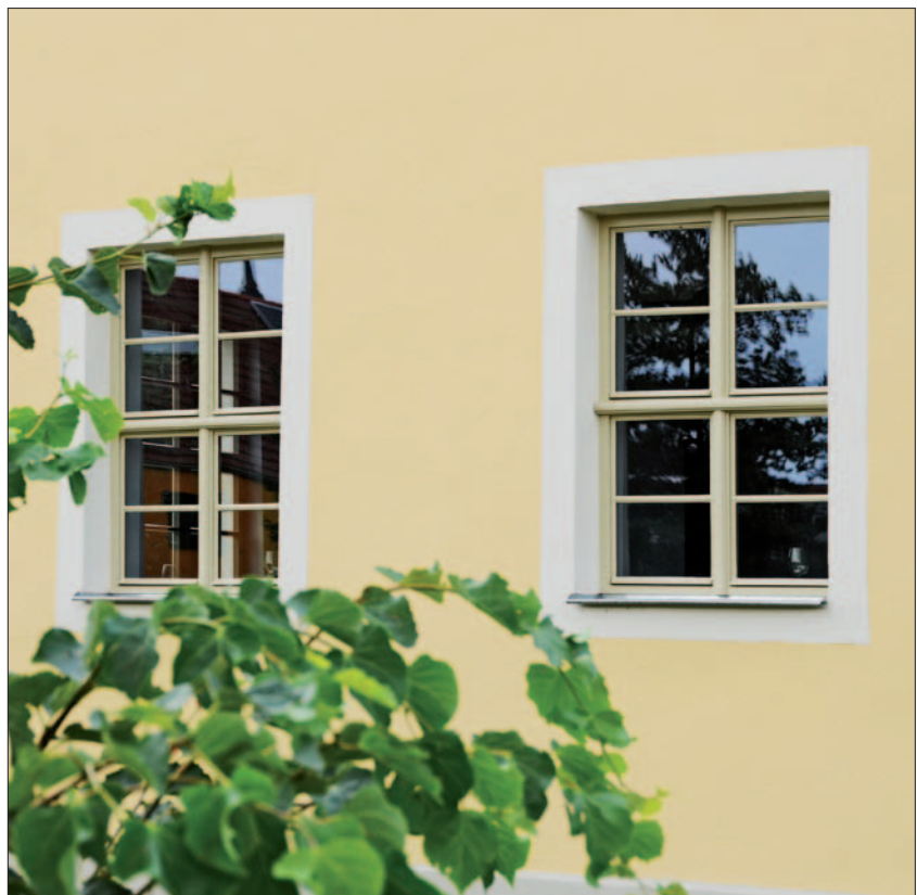
PaXrestora im denkmalgeschützten Schillerhaus. Besonderer Wert wurde auf die barocke Kreuzstockteilung mit zierlichen Ansichtsbreiten und glasteilenden Sprossen gelegt.
